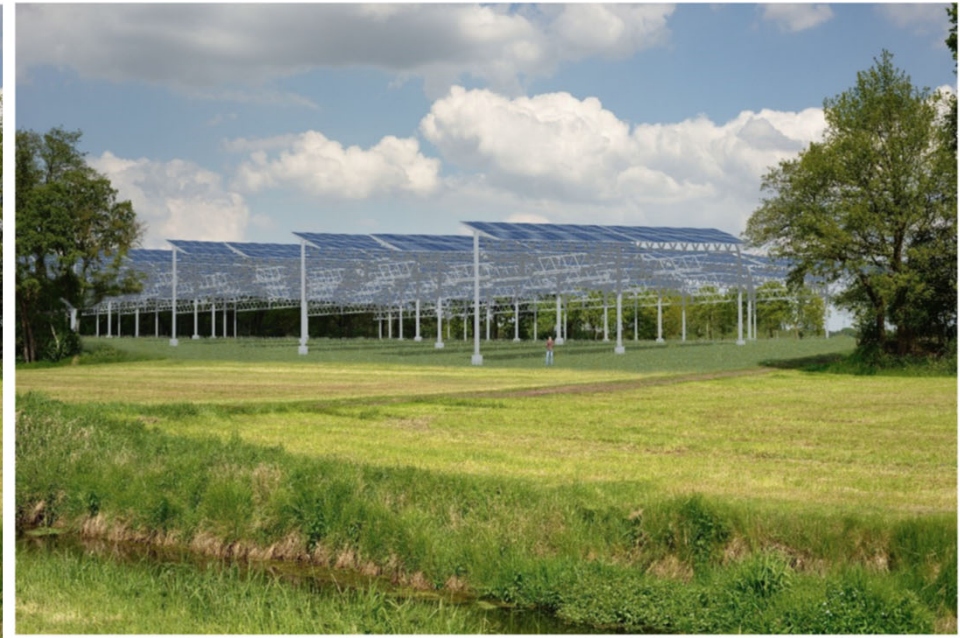
Abb. 10: Hoch aufgeständerte, horizontale Anlage (Naturraum Zevener Geest, Niedersachsen). (© Lenné3D GmbH)
