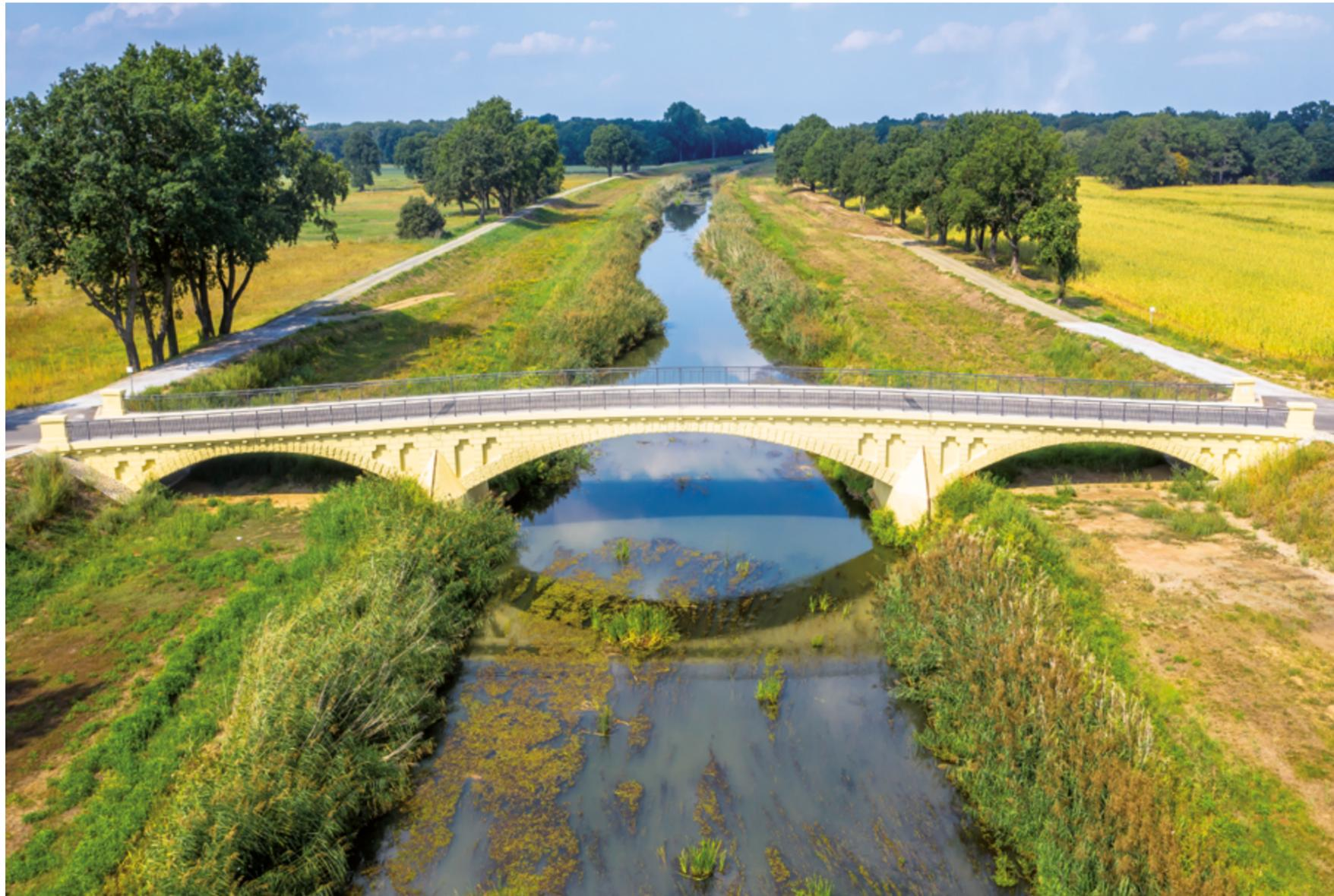
Die drei schlanken Bögen der 1905 fertiggestellten Betonbrücke fügen sich harmonisch in das Landschaftsbild des Flusslaufes der Schwarzen Elster ein. Die Gesamtlänge der 6,40 m breiten Brücke beträgt 70 m und wird durch ein 27 m weites Mittelfeld sowie zwei 18 m große Randfelder geformt, die nur bei Hochwasser Wasserläufe überspannen.
