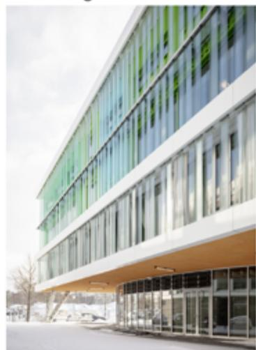
Lüftungstrichte Doppelfassade mit Profilsystem über zurückspringendem Erdgeschoss
