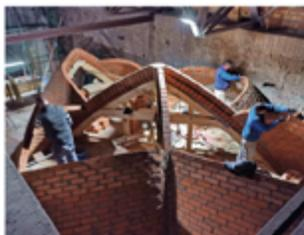
Baustellenschnitt, Mauerer beim Ausmauern der Rippen
